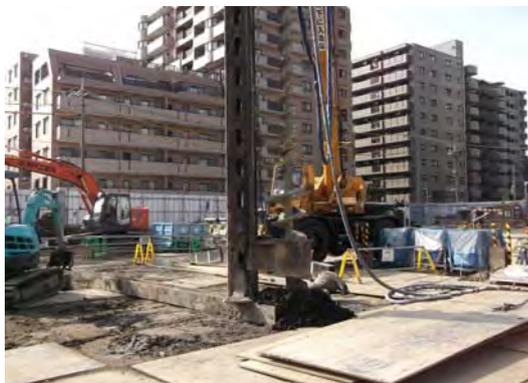
※長尺物のH鋼を打設する現場 (H400×400、18m 打設)
