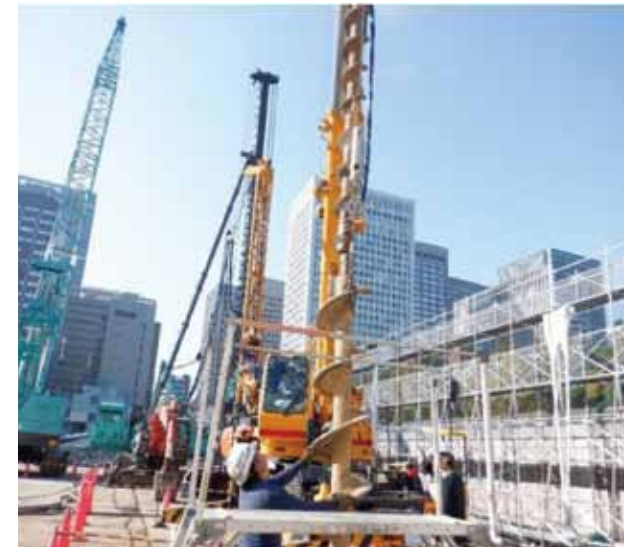
■ スクリューはめ込み前状況
