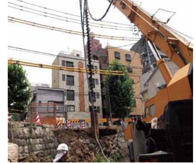
■ 上段への打設状況 (ケーシング) [障害物除去バージョン]
