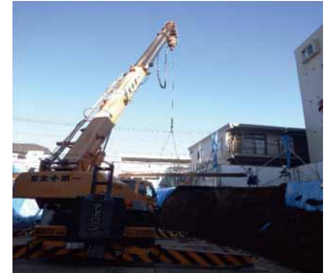
■ スクリューを外しての楊重作業状況
