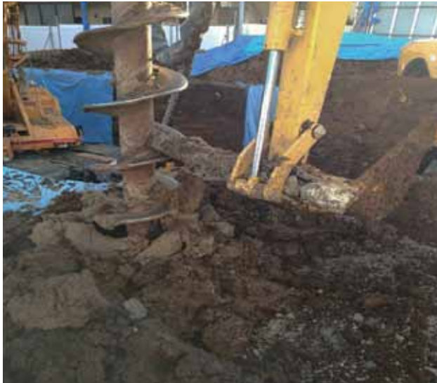
■ スクリュー引上状況 (コンボ泥取り)
