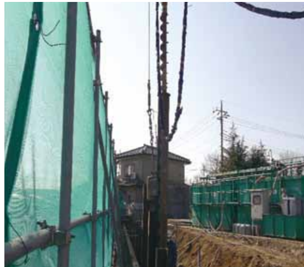
■ H 鋼モンケン打設状況
