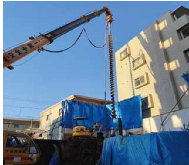
■ H 鋼建込み開始状況
