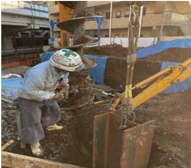
■ H 鋼建込み完了状況
