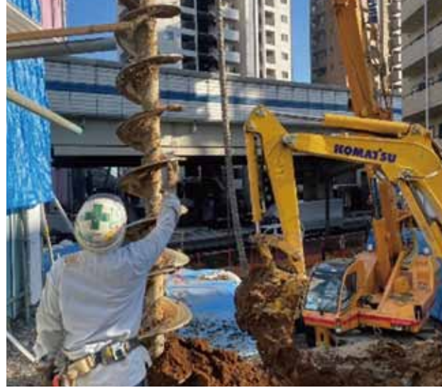
■ 削孔状況 (スクリーアの建ち合せ状況)
