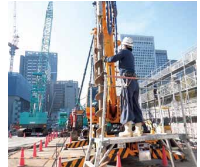
■ スクリューはめ込み後状況
