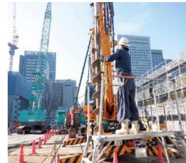
■ スクリューはめ込み後状況
