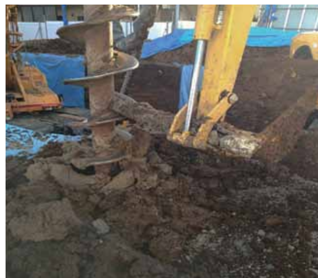
■ スクリュー引上状況（コンボ泥取り）
