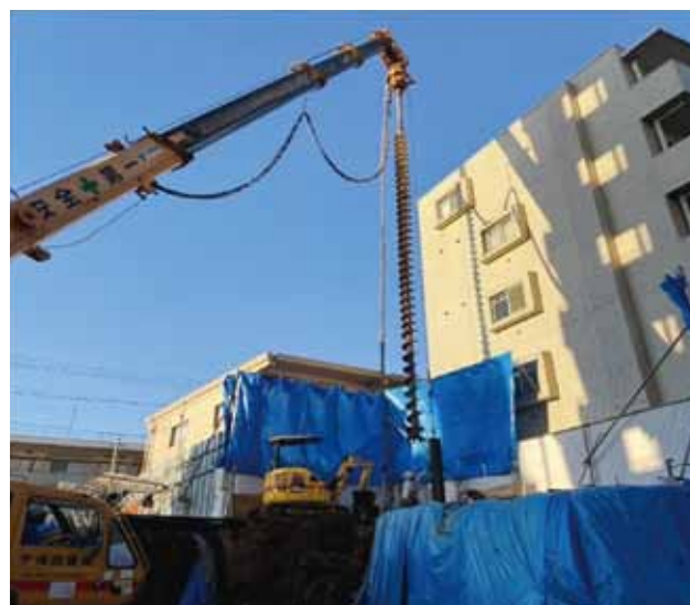
■ H 鋼建込み開始状況
