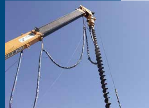
※硬質土削孔状況
