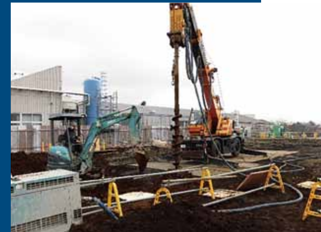
※油圧 LHV 取付け状況
