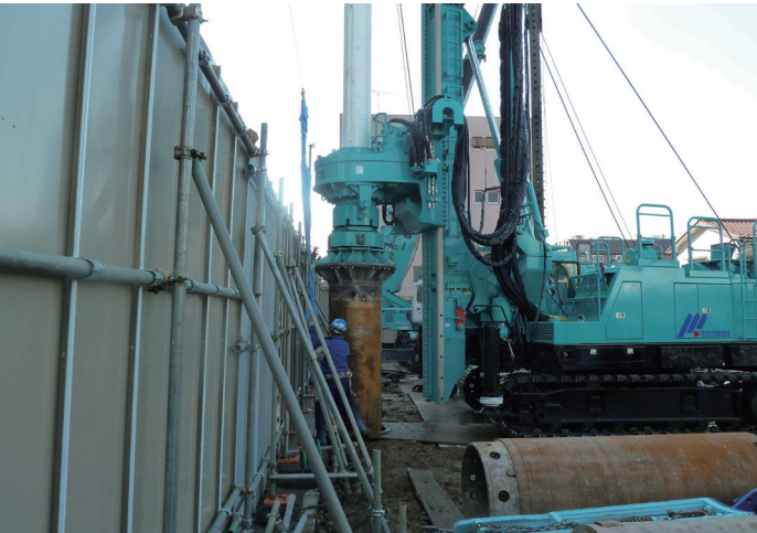
■境界地施工状況
