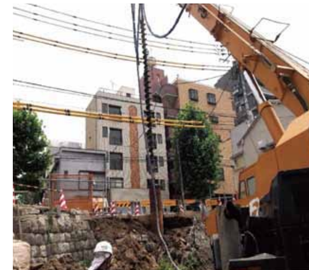
■ 上段への打設状況（ケーシング） [障害物除去バージョン]
