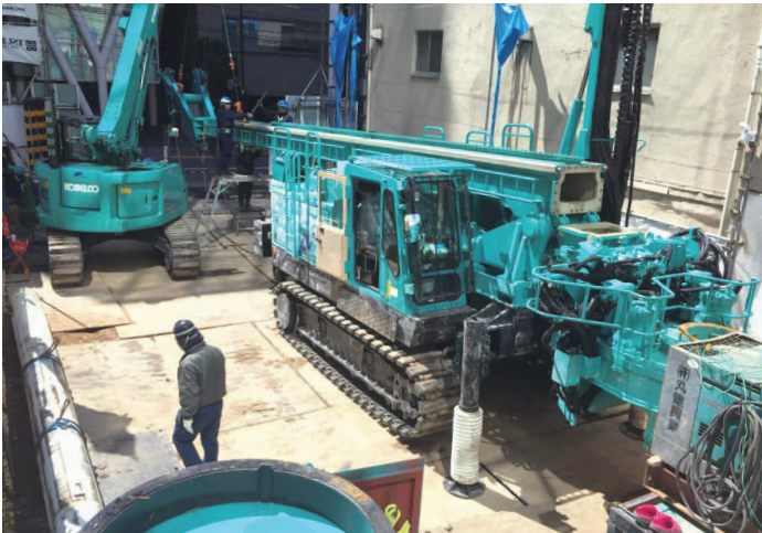
■狭隘地施工状況
