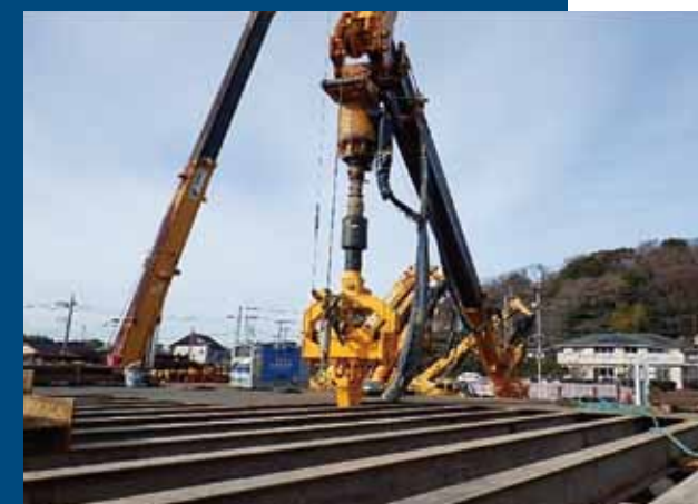
※油圧 LHV 施工状況
