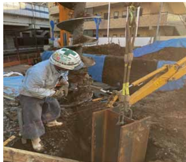
■ H 鋼建込み完了状況
