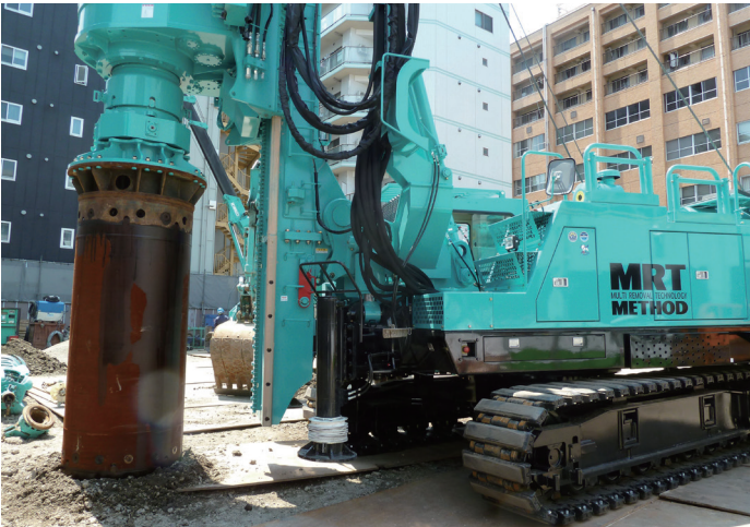
■ケーシング掘削状況
