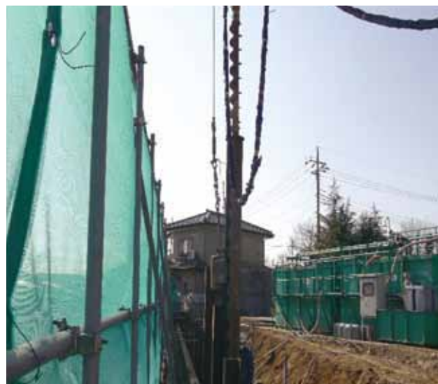
■ H 鋼モンケン打設状況
