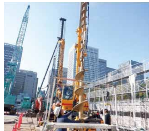
■ スクリューはめ込み前状況
