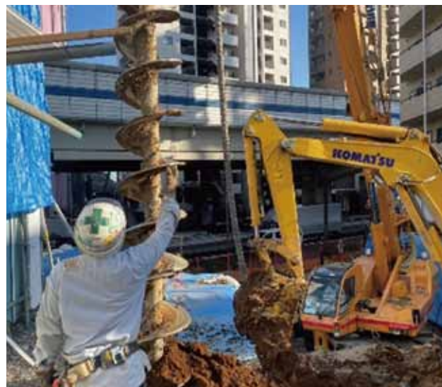
■ 削孔状況（スクリューの建ち合せ状況）
