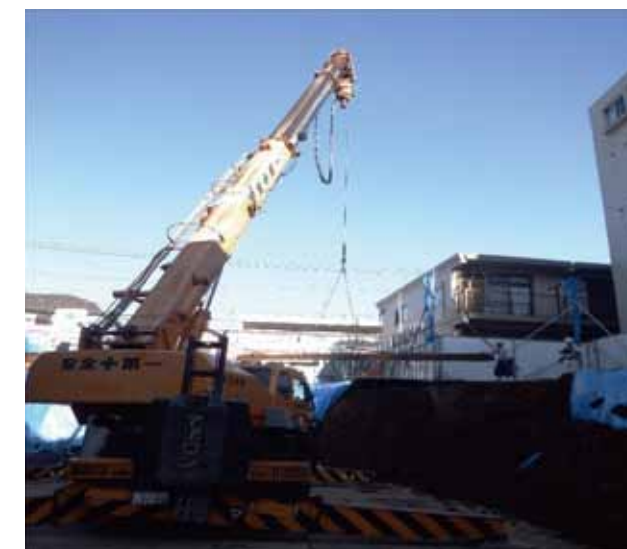
■ スクリューを外しての楊重作業状況
