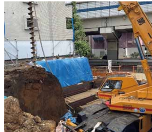
■ 上段への打設状況（オーガー） [H 鋼打設バージョン]
