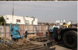
※土丹層先行削孔後、シートパイルをパイラーで圧入(引抜)した現場
