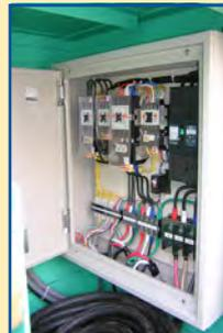
配電盤には、感電事故を防ぐ為漏電遮断機を装備、及びモータの過負荷保護を行う熱動形過負荷継電器（サーマルリレー）を装備しています。
