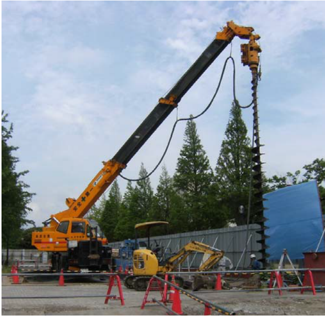
16tアンギラス 作業半径11m \phi 500削孔長11m施工中(写真) 16tベースで25tアポロンクラスの作業半径が可能 狭小地での施工や特車申請不要が強み
