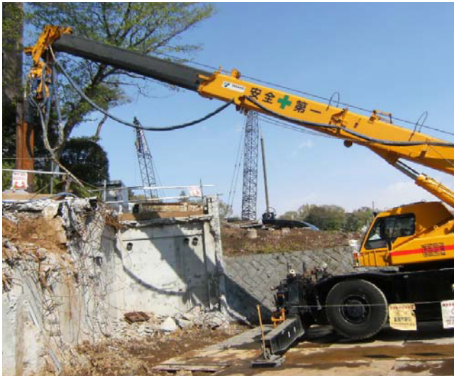
段差打上げ 高台などへの打上げはリーダーの無い分 キリを長く繋げる事が出来、ジョイントの数を減らせる
