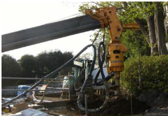
■上空制限の施工 3mキリ5本ジョイント、杭H350を4本ジョイント(写真) 短いキリを組立削孔、切り離し、建てみする事で 高さ制限のある位置での施工を可能にした
