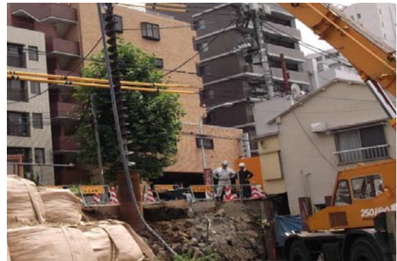
■斜面打ち 打設盤が斜面の場合でも施工可能
