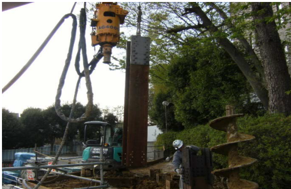
■モンケン打設 キリにリーダーを接続し、 壁際でのモンケン打設を可能にした
