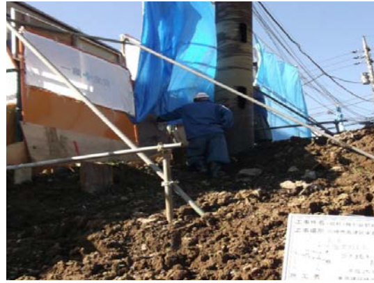
■斜面打ち 打設盤が斜面の場合でも施工可能
