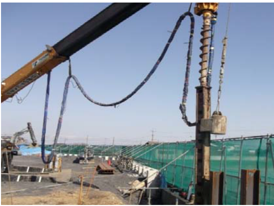
■モンケン打設 キリにリーダーを接続し、 壁際でのモンケン打設を可能にした
