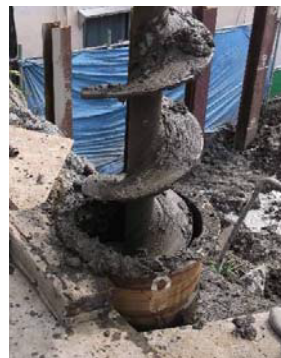
■特殊作業 間知石を撤去後、中を削孔し、ミルク注入 H鋼打設とした
