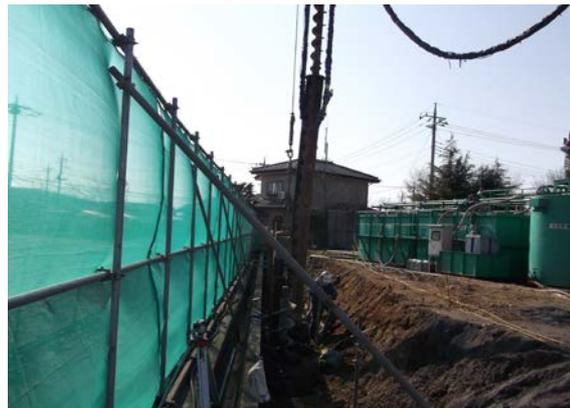
※モンケン使用によるH鋼を打設する現場 (H300×300、10m打設)
