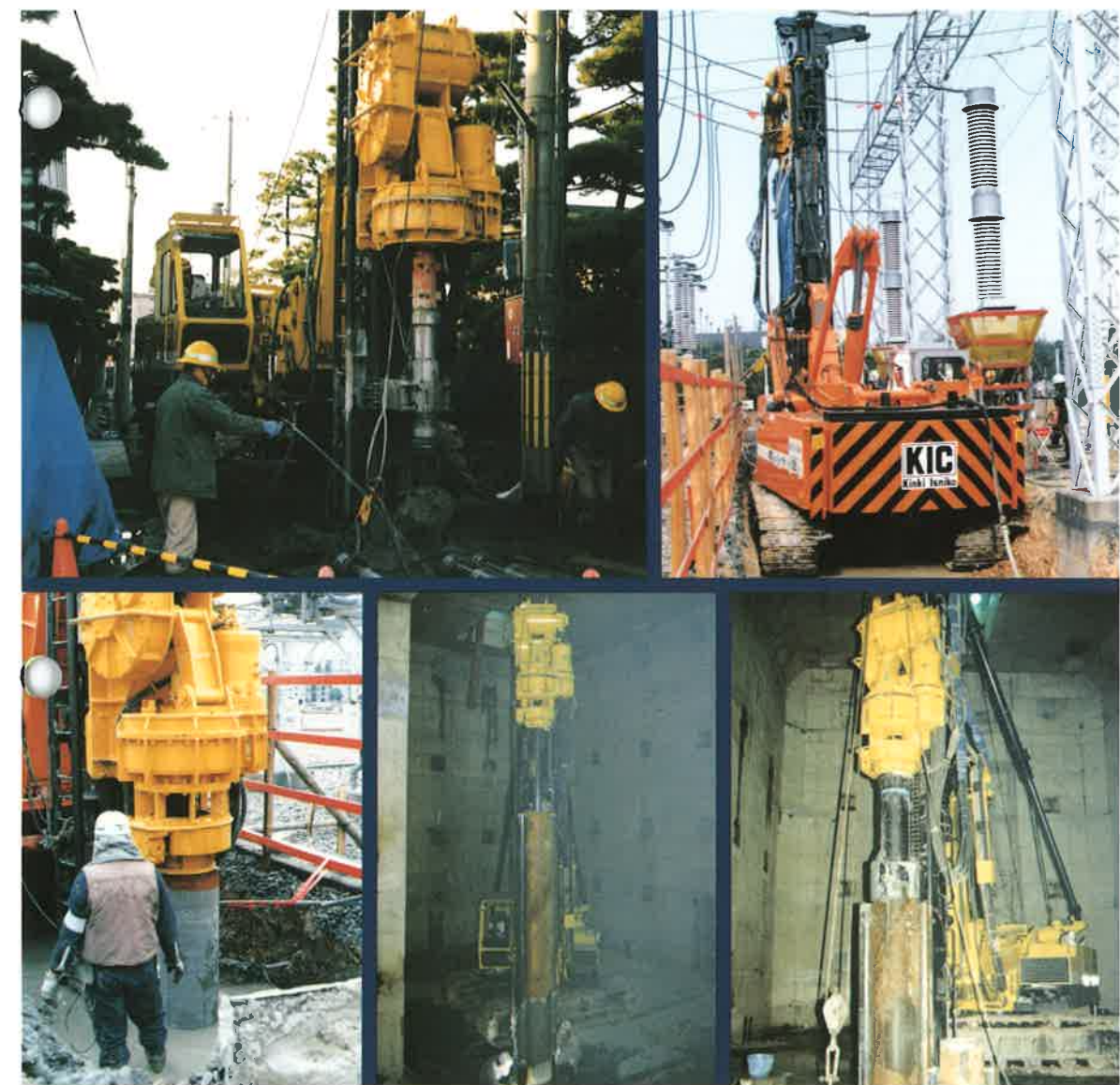
① 地盤改良工法 4m市道路上 ソイルセメント φ600 2m×5 大阪府堺市
