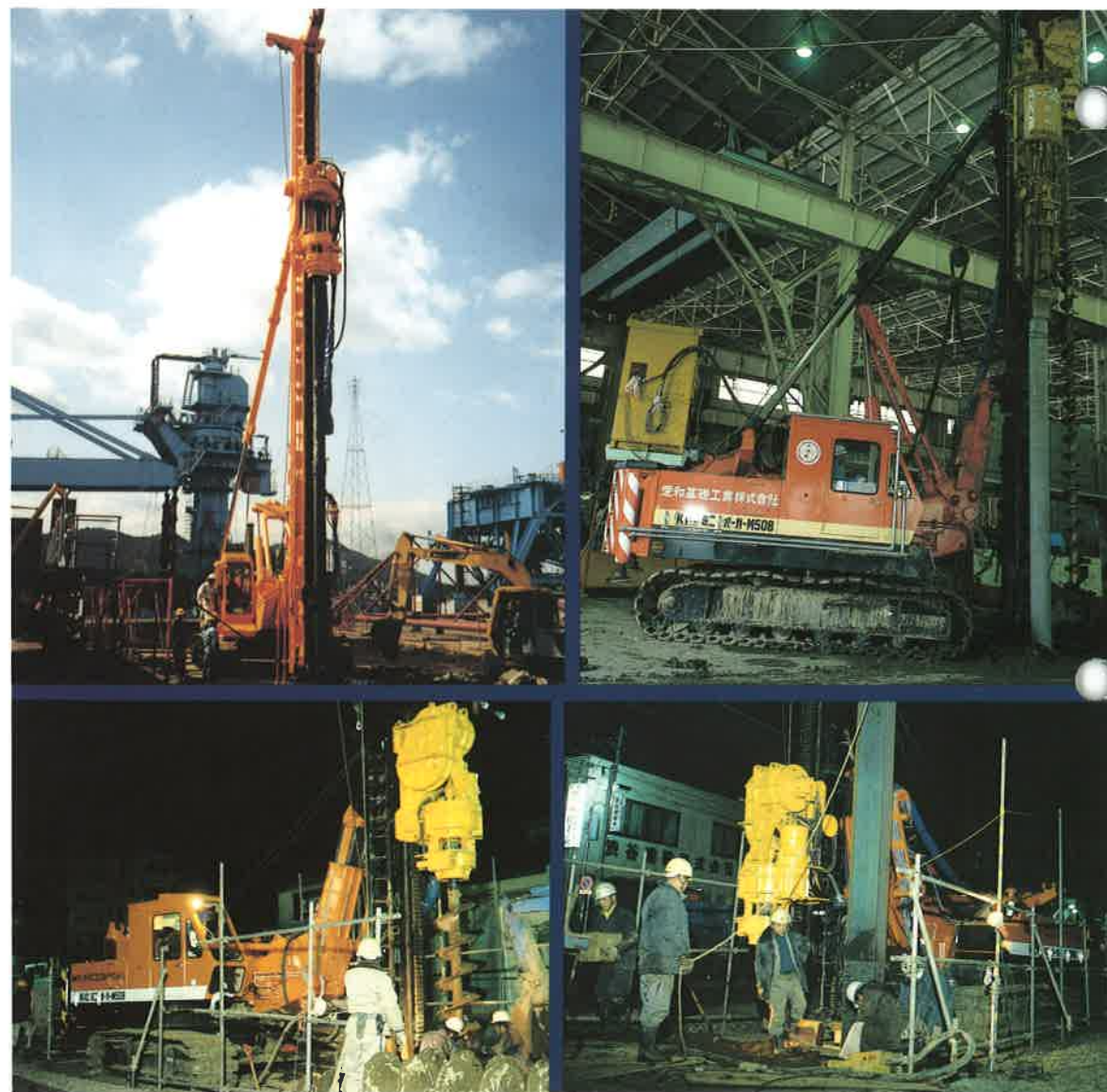
① アスコラム工法 (ソイルコラム) φ1050 6m 愛媛県新居浜市
